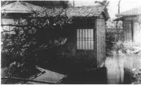
写真1 山崎園の池の上に建てられた浴室
