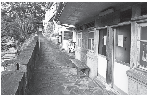
写真2 河津町・湯ヶ野区共同浴場
