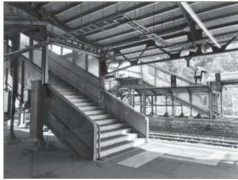
写真1 JR登別駅の跨線橋
