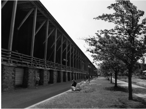
写真2 バート・デュルクハイムのクアパーク。 建造物は枝状架装置。 (注)筆者撮影。2013年7月。
