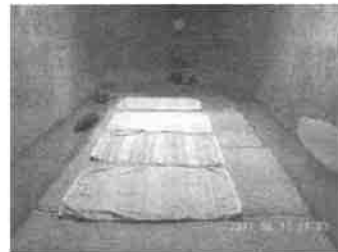
写真4 釜風呂の内部
