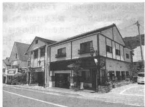
写真2 ファサード整備された家屋 (注)筆者撮影。2009年10月4日。
