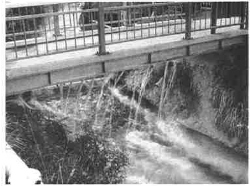
写真10 草津中和工場の湯川への石灰ミルク注入
