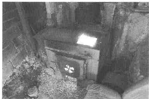
写真4 改良したボイラー
